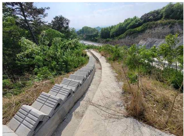
점검계단, 산마루측구 전경
