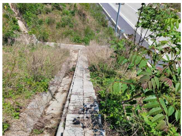
상부 사면 점검시설
