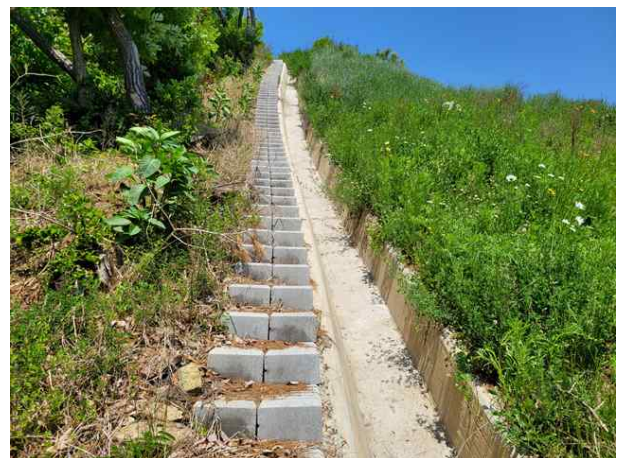
산마루측구, 점검계단 전경
