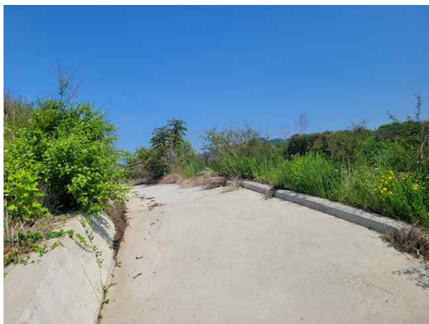
소단 배수로 전경
