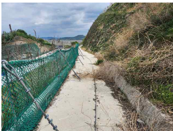
소단 배수로 전경
