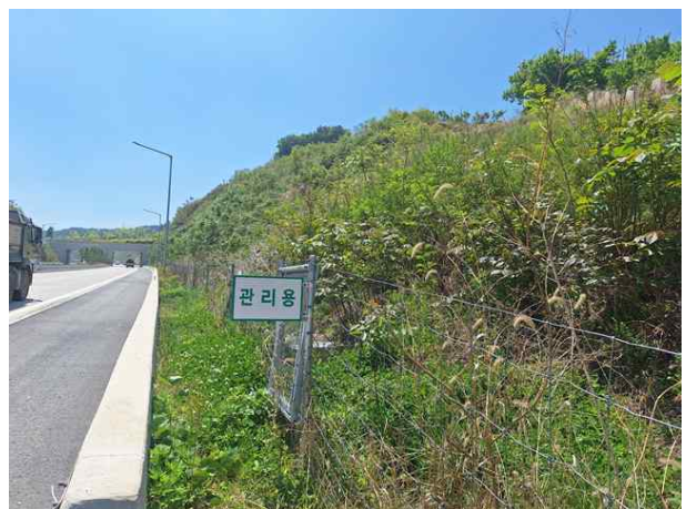
하단 야생동물유도울타리 전경
