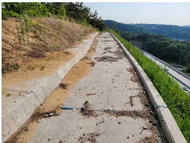
소단 배수로 전경
