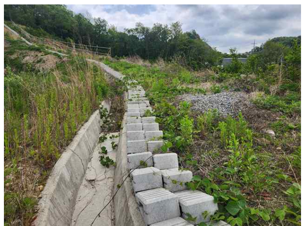
산마루측구, 점검계단 전경
