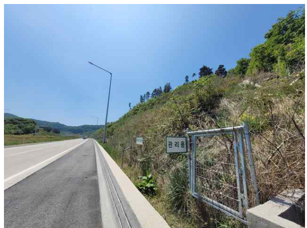
하단 야생동물유도울타리 전경
