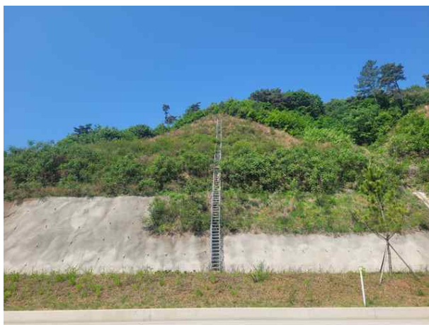
쑛크리트, 계단식옹벽 전경
