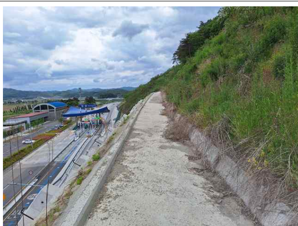
소단 배수로 전경
