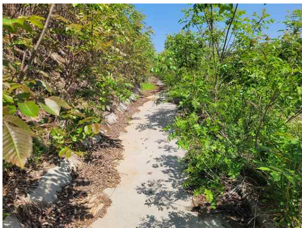
소단 배수로 전경
