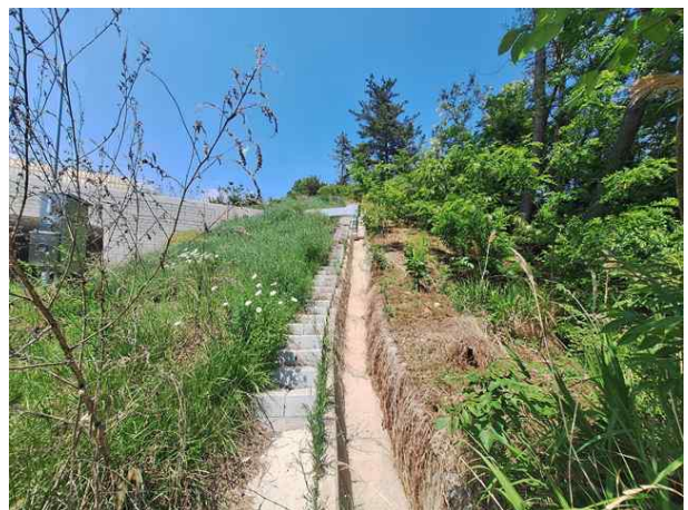
산마루측구, 점검계단 전경
