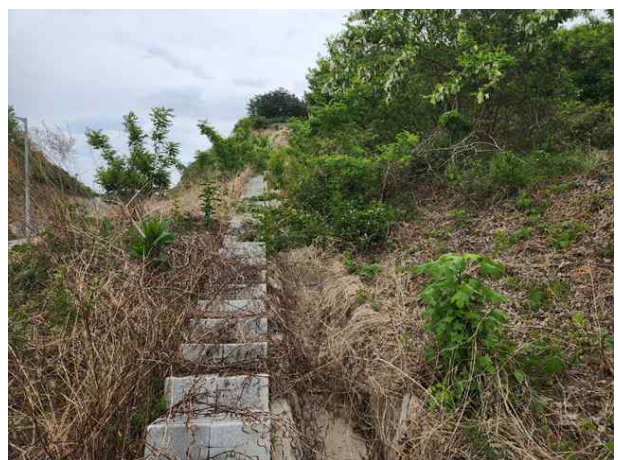
산마루측구, 점검계단 전경
