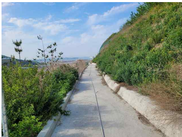
소단 배수로 전경
