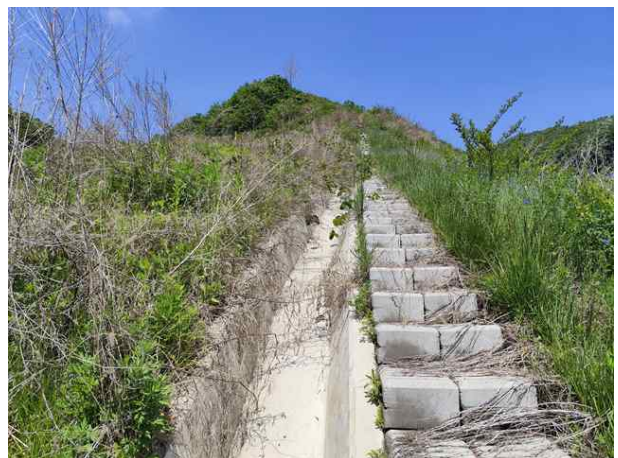
산마루측구, 점검계단 전경
