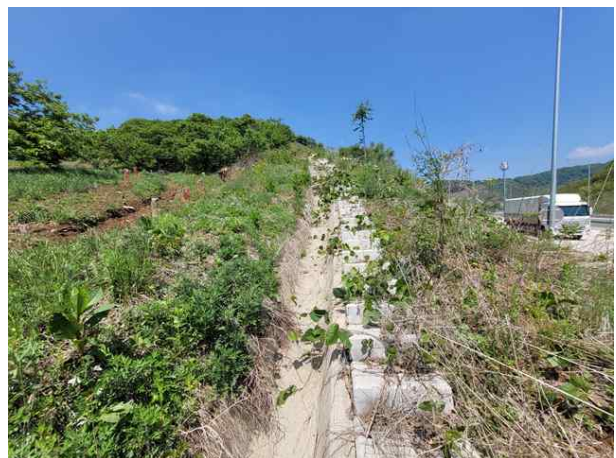
산마루측구, 점검계단 전경
