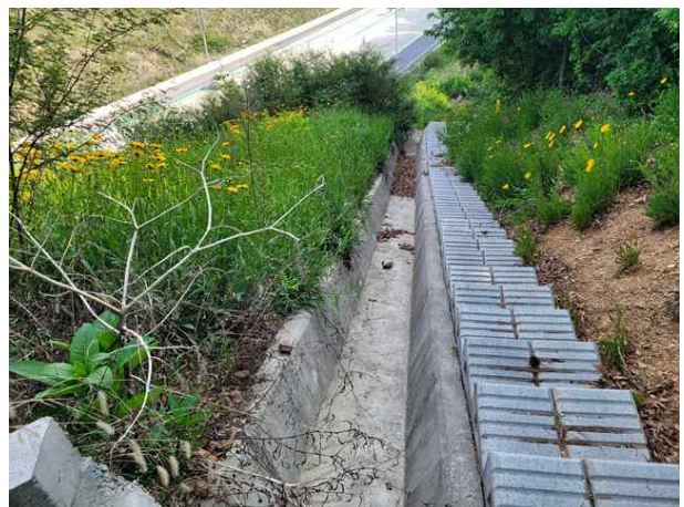
점검계단, 산마루측구 전경
