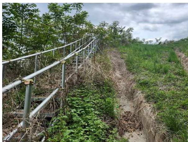
산마루측구, 점검계단 전경
