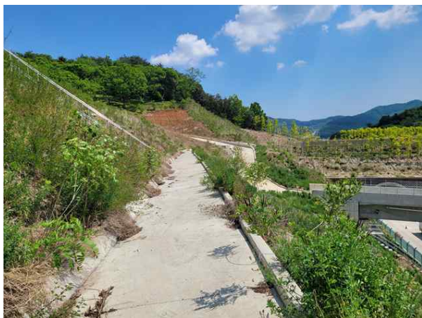
소단 배수로 전경
