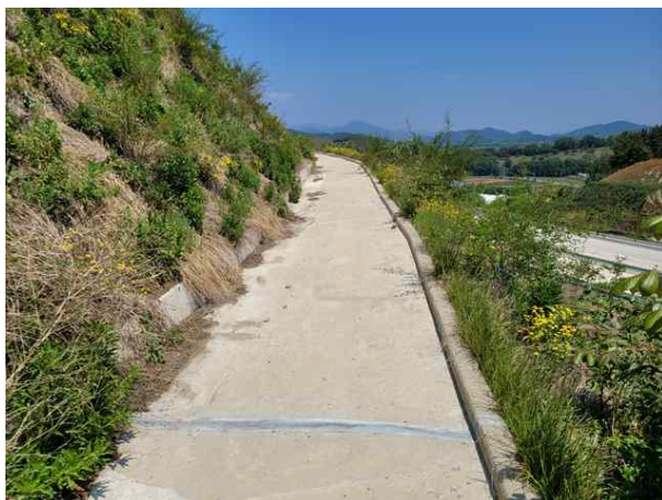
소단 배수로 전경
