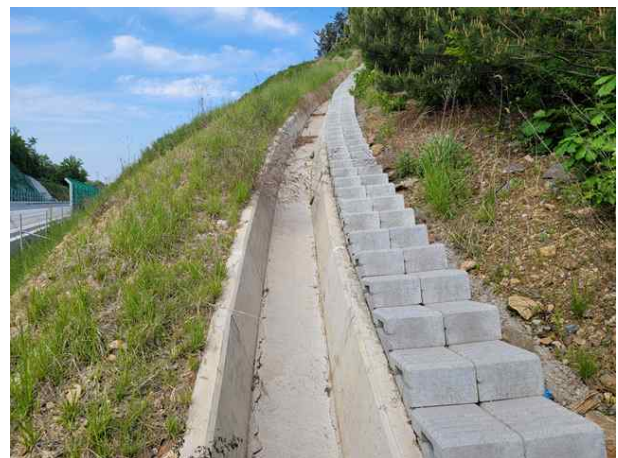
점검계단, 산마루측구 전경
