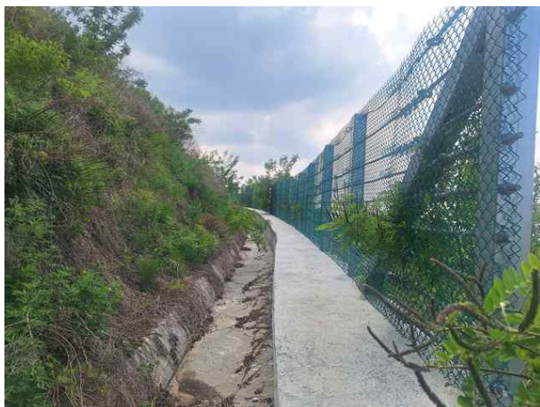
소단 배수로 전경
