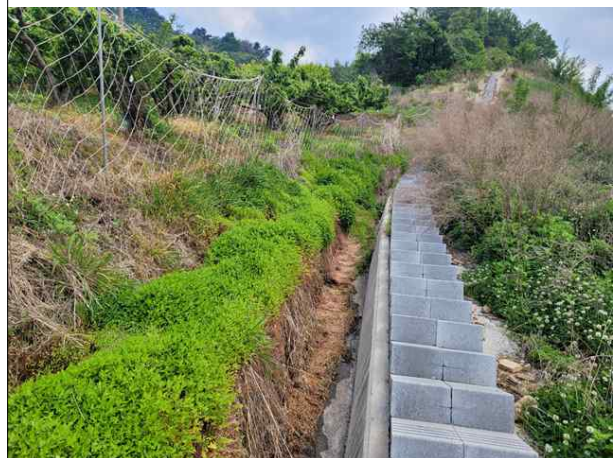
산마루측구, 점검계단 전경
