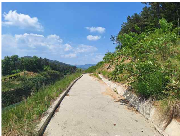
소단 배수로 전경
