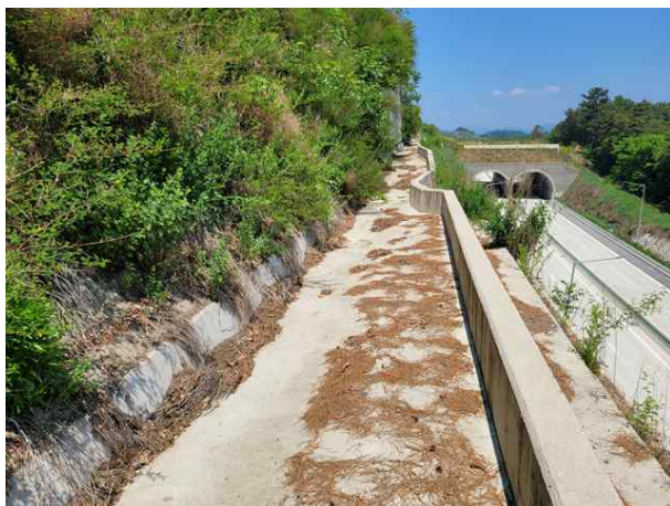
소단 배수로 전경
