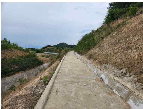
소단 배수로 전경
