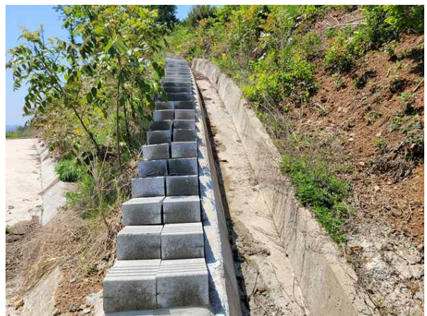
산마루측구, 점검계단 전경
