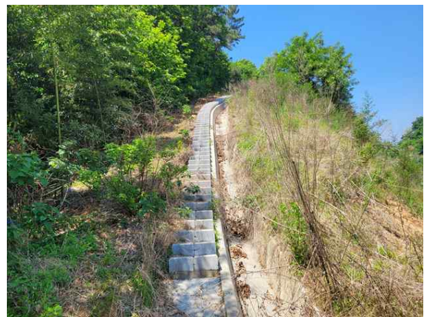
산마루측구, 점검계단 전경
